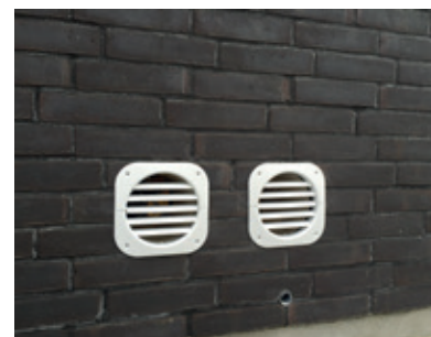
Varmeafgivelse til det fri, bag ved køleanlægget
